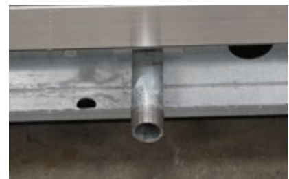
Kondensatwannenanschluss
