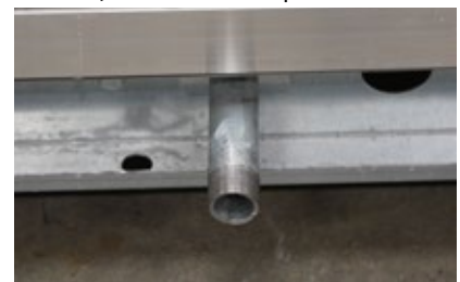
Conexión de la bandeja de drenaje
