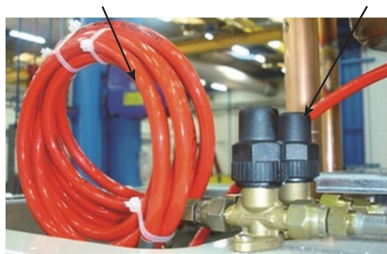
Líneas de alta presión preparadas para conectarse a la válvula
