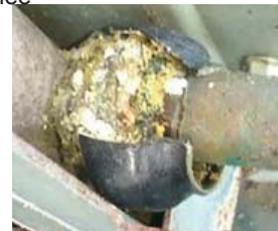
Corrosion galvanique sous la gaine en plastique.
