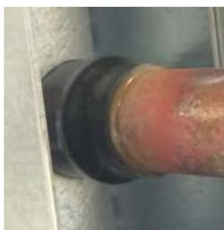
Pour les échangeurs thermiques à micro-canaux, le raccordement entre la batterie et le circuit s'effectue à l'aide d'une soudure cuivre/aluminium. Ce raccordement est protégé contre la corrosion galvanique par une résine spéciale encapsulée dans une gaine thermo-rétractible.
