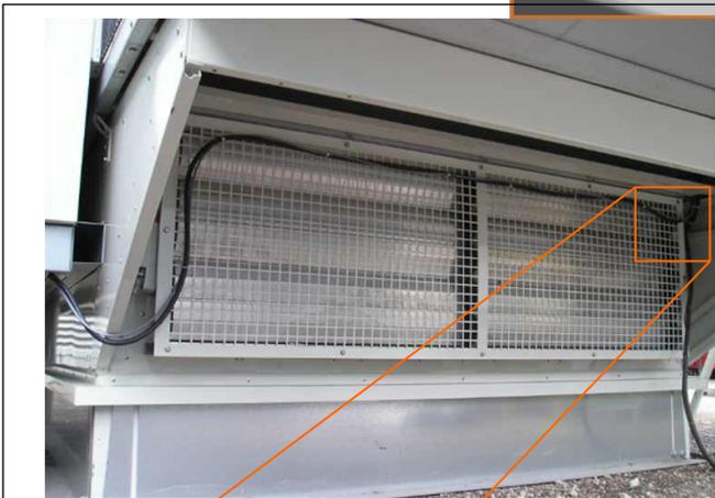
Anschließend die 2 Kabel am Gitter des Abluftsockels befestigen und in den Schaltschrank des Dachklimagesäts einführen.
