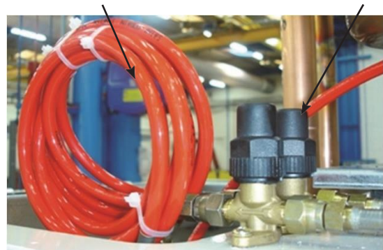
Hochdruckleitungen bereit zum Anschluss an das Ventil
