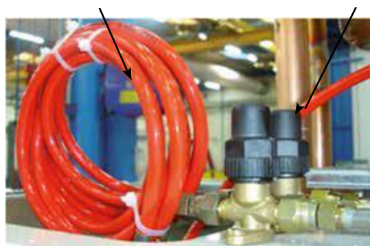
Lignes hautes pression, prêtes au raccordement à la vanne
