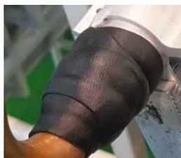
En el caso de intercambiadores de calor de microcanales, la conexión de la batería al circuito se realiza por medio de una soldadura de cobre/aluminio. Esta conexión está protegida de la corrosión galvánica por una resina especial encapsulada en un manguito bituminoso.
