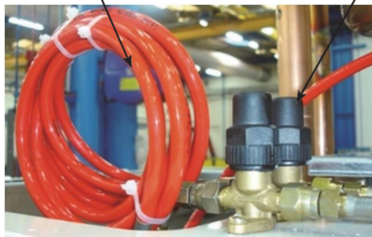
Linee alta pressione pronte per il collegamento alla valvola
